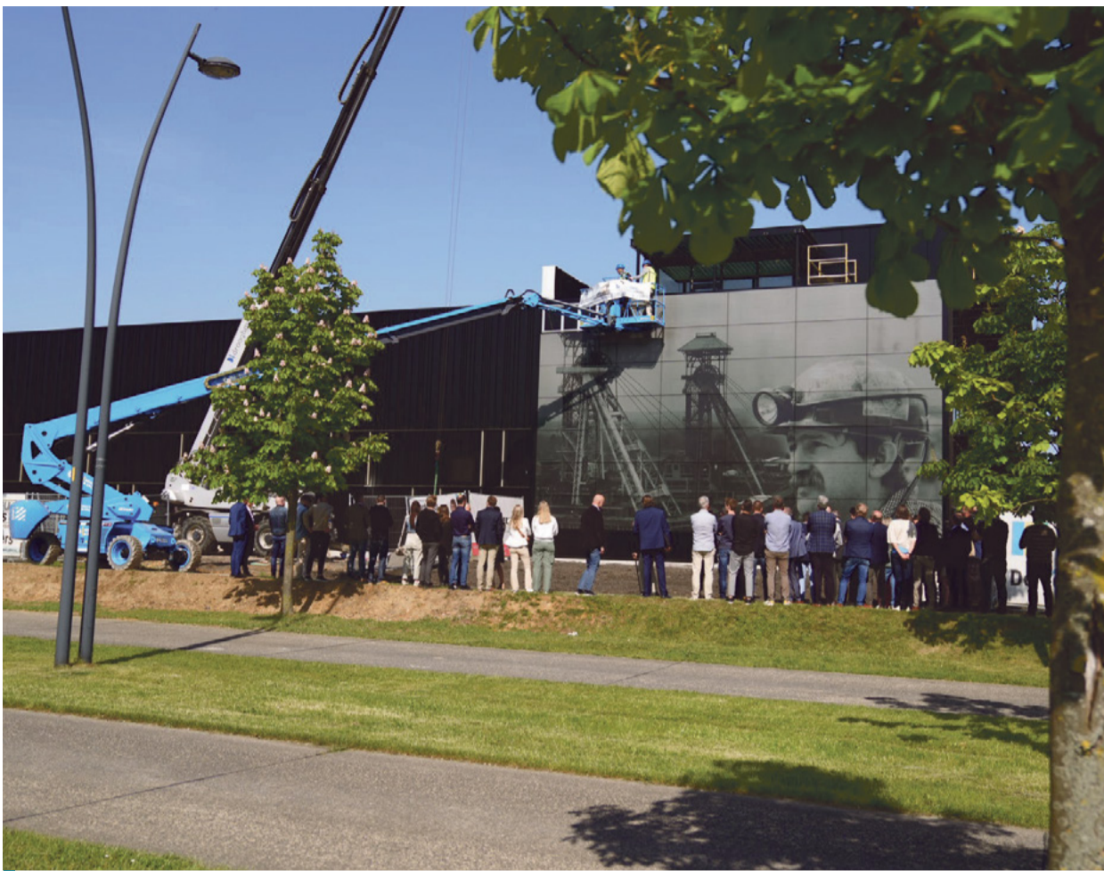
Momenteel realiseert Mathieu Gijbels het nieuwe gebouw van Soltech in Genk, waar einde mei zonnepanelen met geïntegreerde foto's werden geplaatst.
